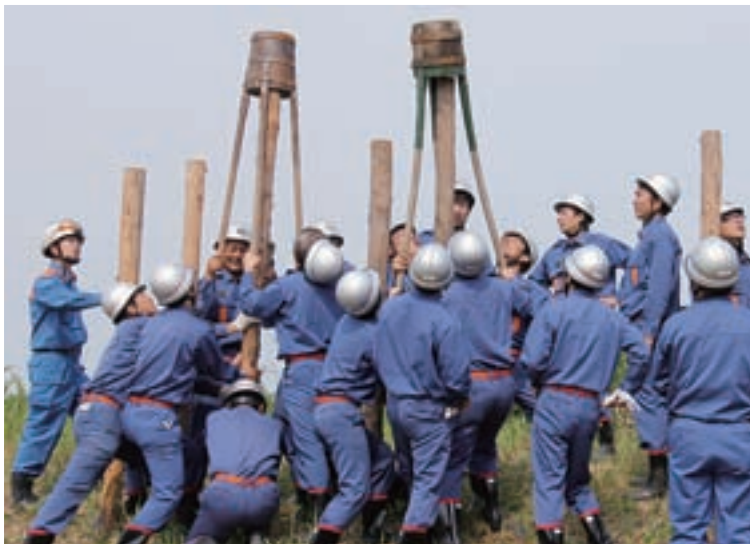
▲杭打ち積土のう工を実践する団員ら
