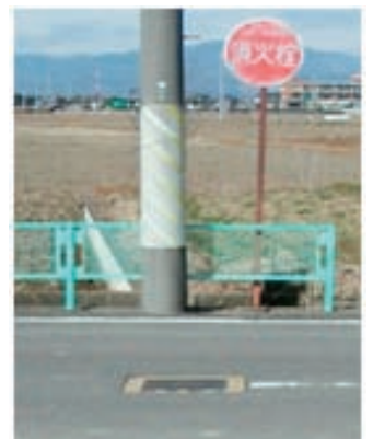
▲地下式の水道消火栓（例）
