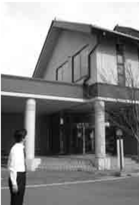
新源泉の掘削を終え、良質の温泉が確認された安八温泉。10月のリニューアルオープンに向けて温泉施設の改修が行われます
