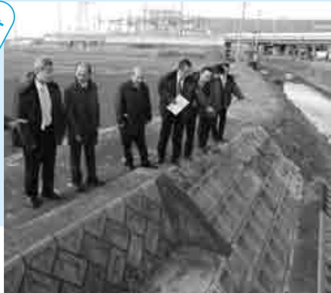
大江川の改修工事の現場を視察しました
