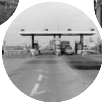
大垣一宮線開通 (昭和 37 年)
