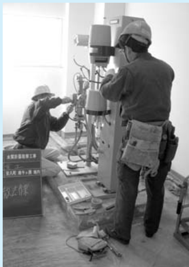
水質計器の取り替え工事の様子（水道事務所）
