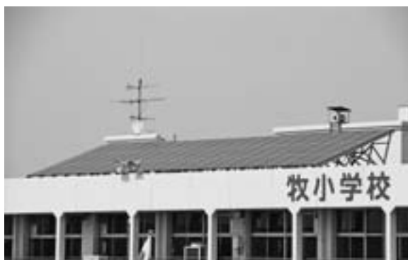
牧小学校に設置された太陽光発電システム
