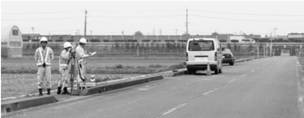
スマートインターチェンジに接続予定の県道間アクセス道路建設の測量を始めました
