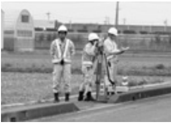
測量が始まったアクセス道路予定地
