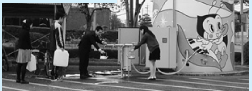
防災時には蛇口が取り付けられ、飲料水を供給するセーフティタワー
