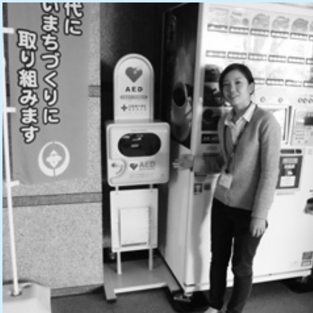
役場庁舎内に設置されているAED
