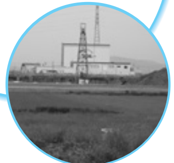
企業誘致に伴う新工場建設現場
