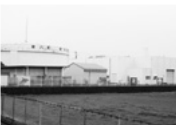
現在の配水場
