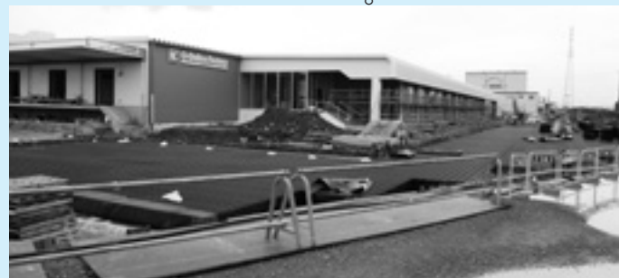
企業誘致による新工場建設現場の様子
