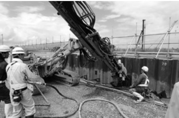
8月末現在のスマートIC建設工事現場の様子
