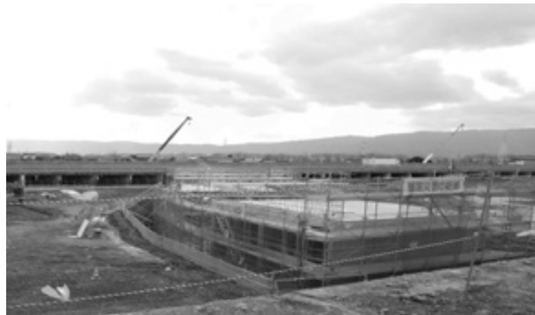
(仮称) 安八SIC建設工事現場の様子（12月現在）
