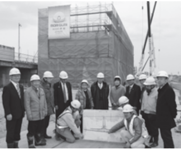
安八スマートIC建設工事現場の様子（3月現在）
