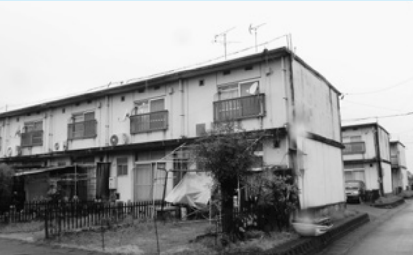
老朽化が進む町営住宅（北今ヶ淵地内）
