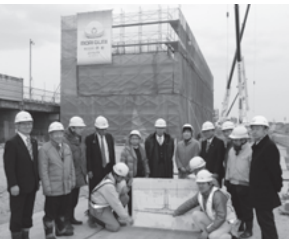
安ハスマートIC建設工事現場の様子（3月現在）
