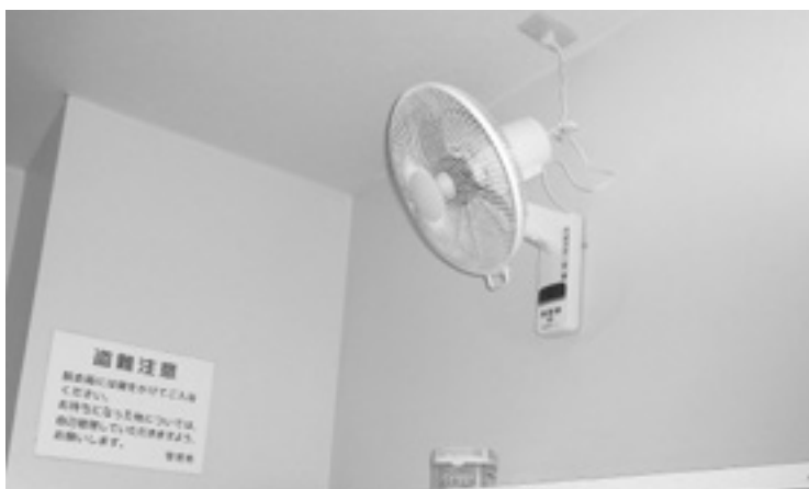
7月11日、男女脱衣室に各1台扇風機を設置しました
