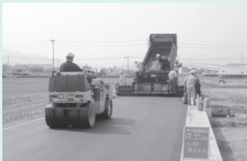
中区墓地南道路拡幅工事
