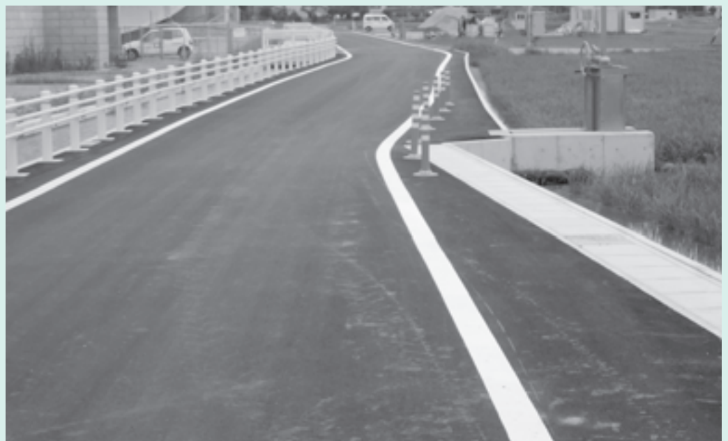
中地区に完成した名神高速道路南側道
