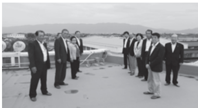
牧小学校屋上から体育館屋根の被害状況を視察
