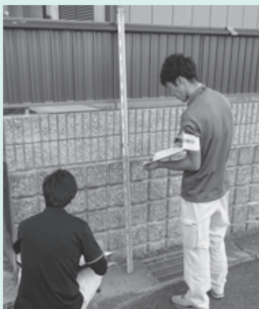
町職員、職員防災士による点検作業
