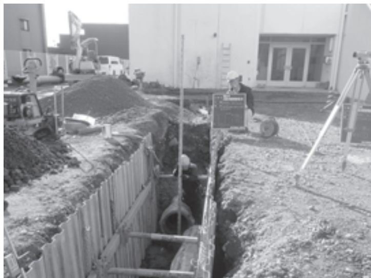
水道排水場の管路布設工事
