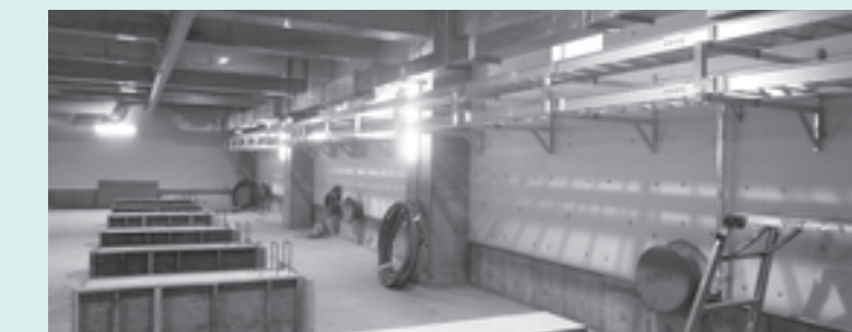
水道配水場施設内部の工事状況
