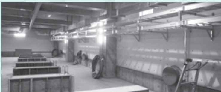
水道配水場施設内部の工事状況
