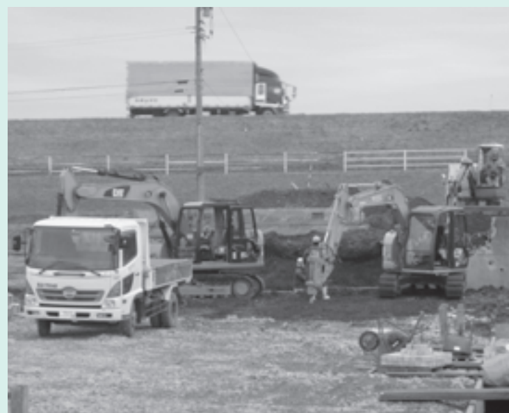
県道間アクセス道路の工事（中地内）
