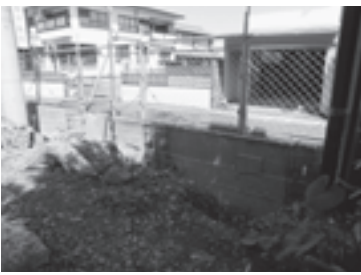
ブロック塀除去工事
