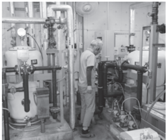
配管の点検作業（安八温泉）
