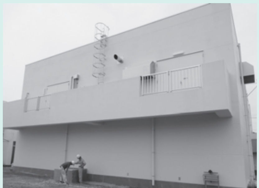
改築された水道管理棟兼配水ポンプ場
