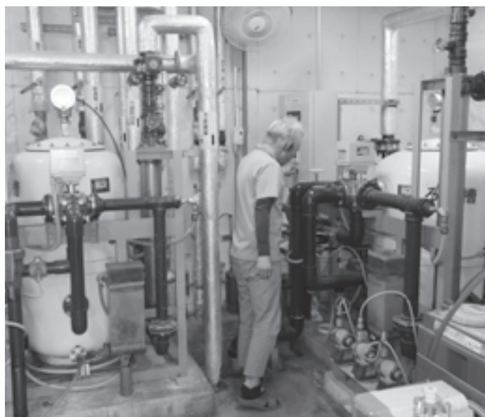
配管の点検作業（安八温泉）
