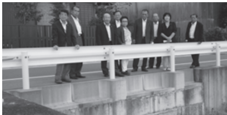
領家地内道路改良工事の完成場所
