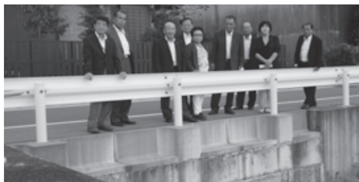
領家地内道路改良工事の完成場所
