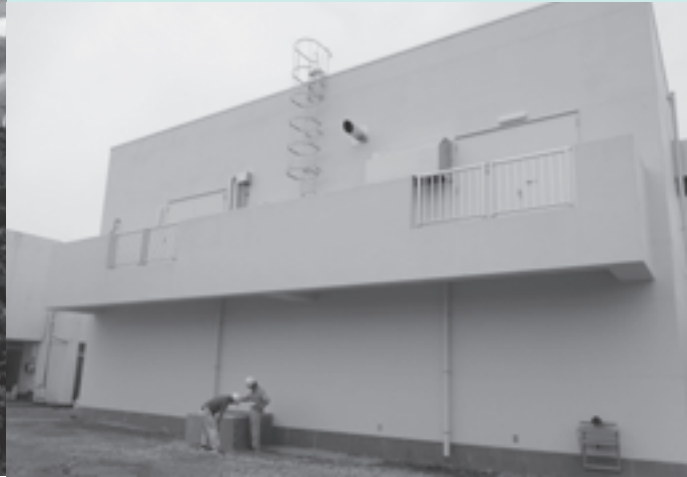
新しくなった水道施設
