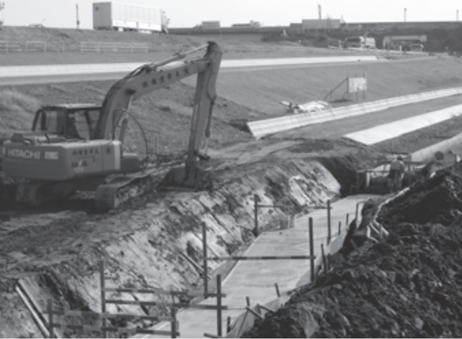
スマートICから長良堤防への取付道路工事
