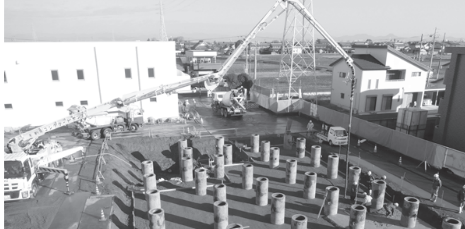
配水池築造工事の基礎工事（水道配水場）
