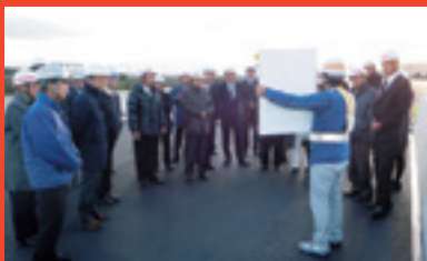
高速道路上で工事概要の説明を聞く
