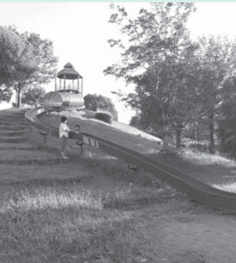
修理が必要なアンヒルパークのローラー滑り台
