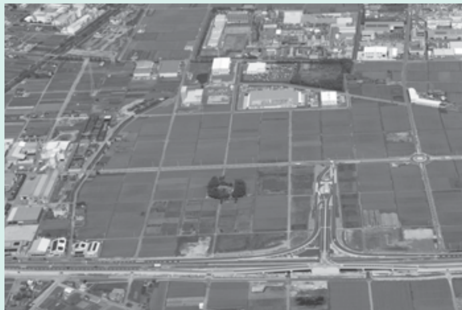
スマートIC周辺の工業団地造成予定地
