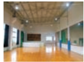
▲東安中学校体育館卓球室 (LED化と吊り天井撤去)
