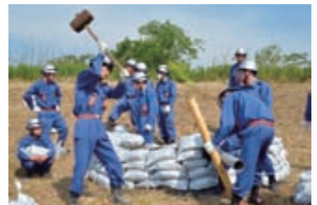
▲水抜き用のパイプを設置
