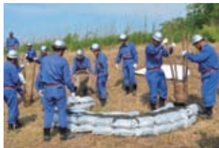
▲土のう袋の向きに気を付けて並べ、転圧
