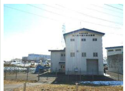
中須川排水機場
