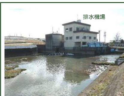
排水機場 採水地点から南西方向
