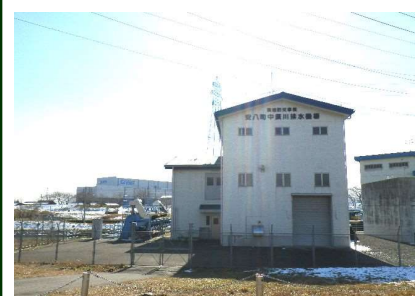
中須川排水機場
