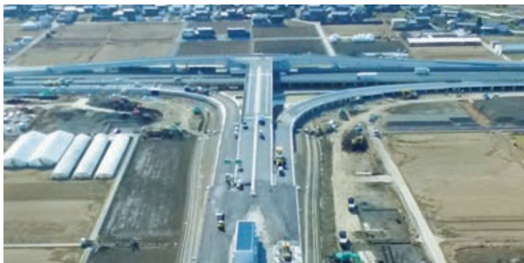
▲建設中の安ハスマートインターチェンジの様子（2月7日）
