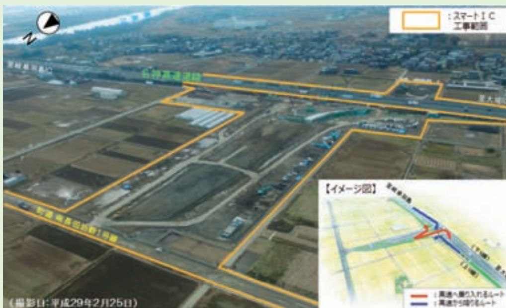
スマートインターチェンジの工事状況 資料提供：NEXCO中日本（株）名古屋支社
