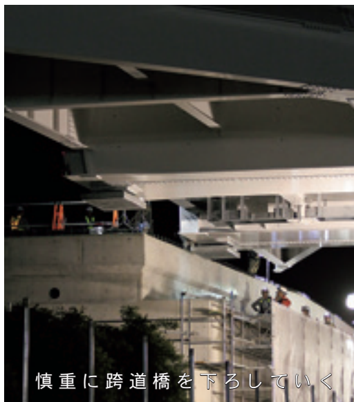
2台の台車を用いて架設部分に跨道橋を運ぶ（名神高速道路本線上にて）
