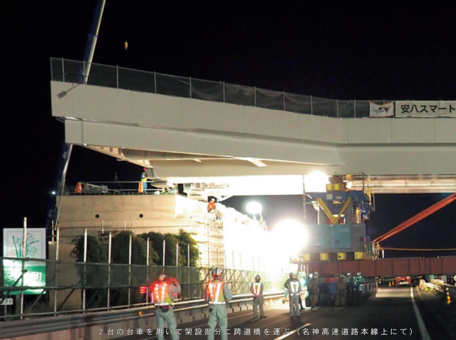
2 台の台車を用いて架設部分に跨道橋を運ぶ（名神高速道路本線上にて）
