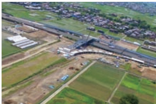
▲7月6日時点の建設状況
