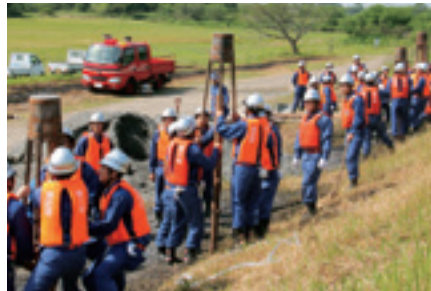
▲たこ槌を使っての杭打ち作業
