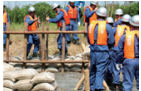
▲土のう袋の向きに気を付けて 並べ、転圧
