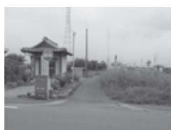
道路改良予定の町道
