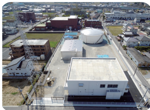
▲上水道配水場（令和2年度完成）
