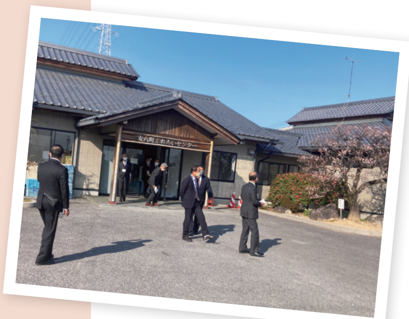
▲改修工事が完了した「安八ふれあいセンター」
