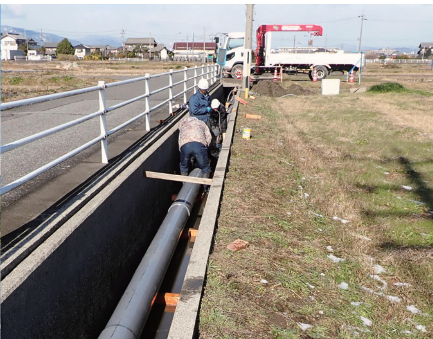
◀ パイプラインを設置する 揖斐川以東用水（南條地内）
