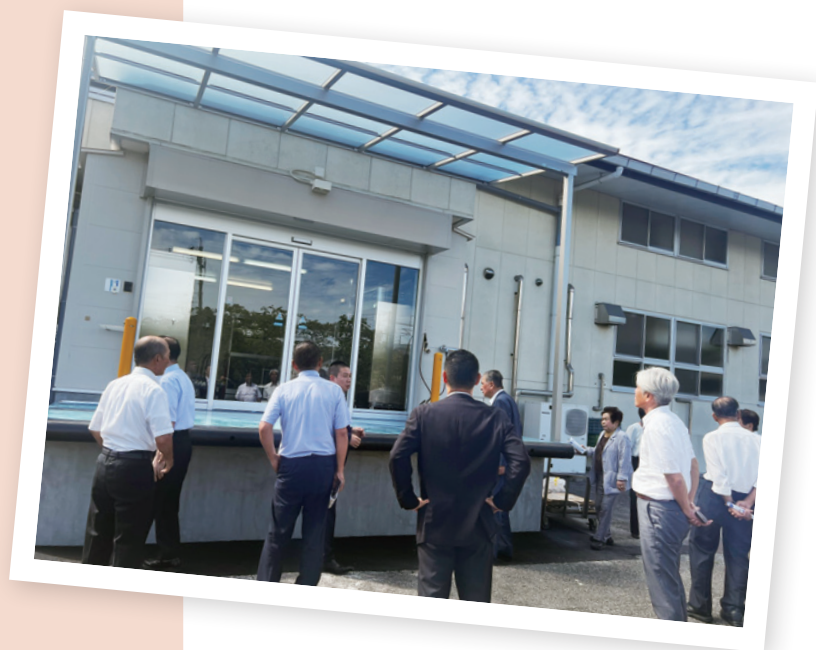
▲工事が完了した給食センター食品保管庫
