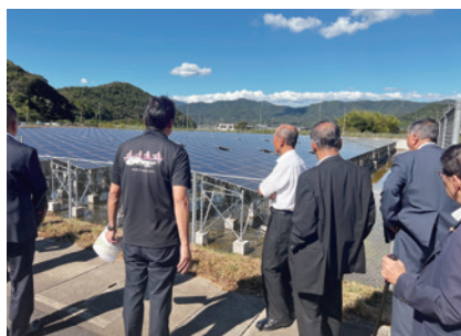
▲調整池にソーラーパネルを設置し有効活用
