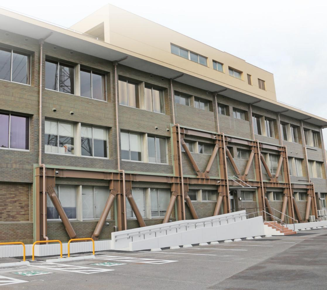
◀耐震補強改修工事が完成した役場庁舎
